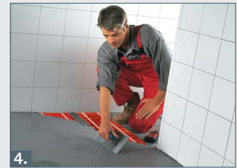
4. Vollflächiges Abziehen des Klebers auf Heizleiterhöhe ca. 2 bzw. 3 mm
