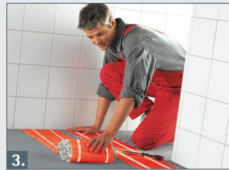
3. Heizmatte am Boden fixieren. Achtung: Heizleiterabstand einhalten und Heizleiter nicht kreuzen.
