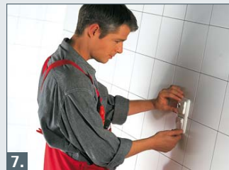
7. Elektrischer Anschluss des Fußbodentemperaturreglers
