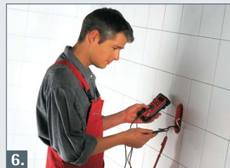
6. Während der gesamten Installation muss der Durchgangswiderstand der Heizmatte gemessen werden.
