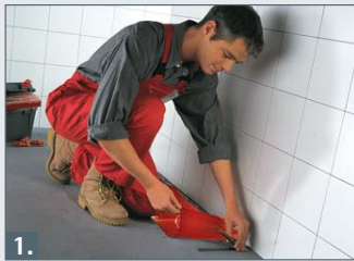
1. Verlegen des Bodentemperaturfühlers. Achtung: Leitung des Fühlers und Anschlussleitung nicht in einem Schutzrohr
