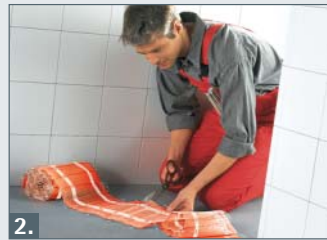
2. Einschneiden der Heizmatte
